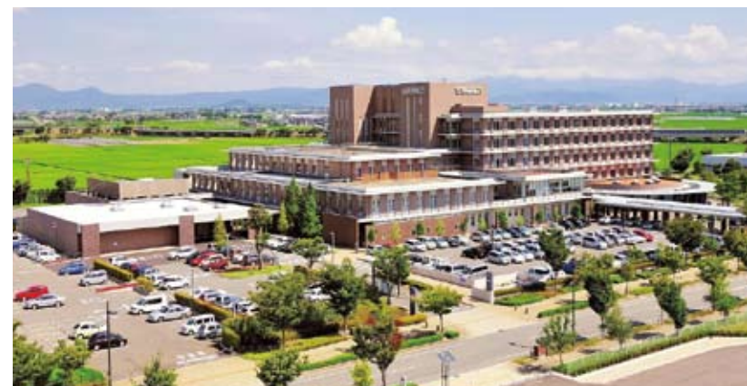
古賀病院 21 の全景（左端の平屋が完成した放射線治療センター）
