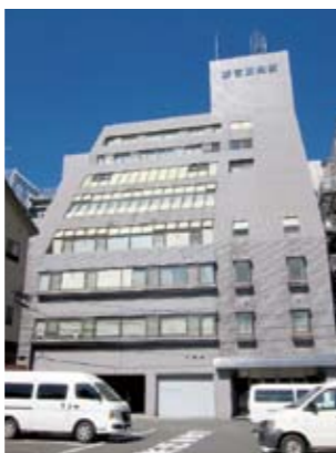
断熱材を張った管理棟東面
